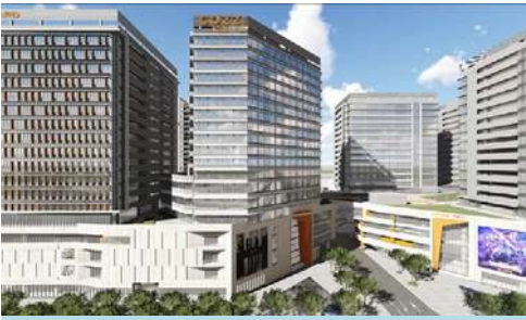
南港調車場商場 (進行中)
